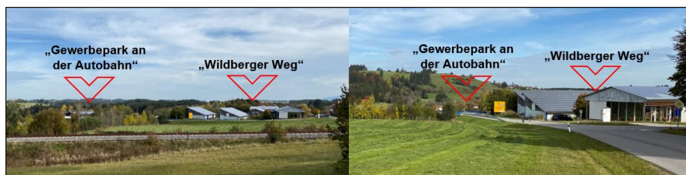
Abb. 9: Blickrichtung von Westen
