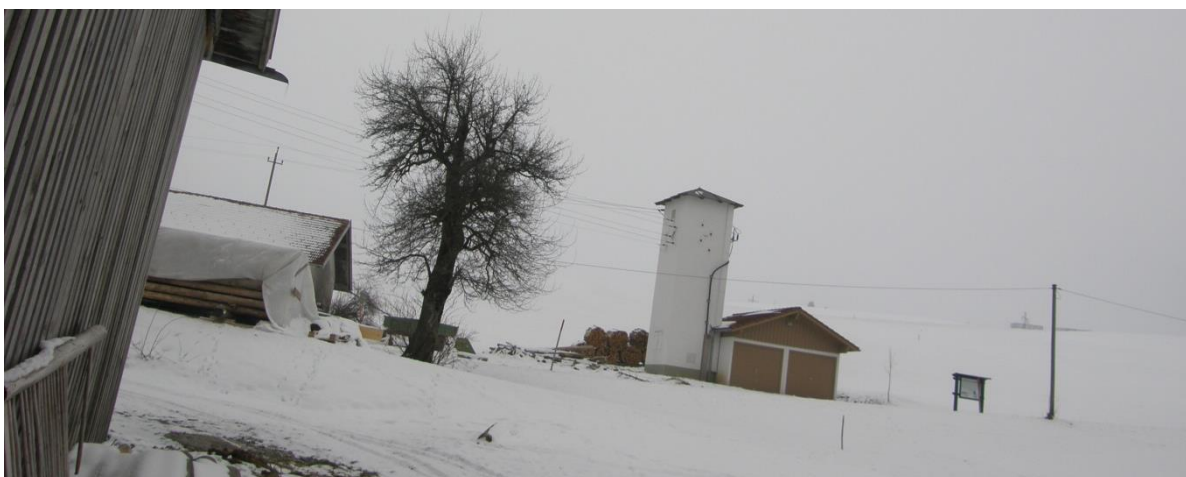
Blick von Norden auf den gegenüberliegenden Ortseingang mit Trafostation, Garagen und Infotafel.
