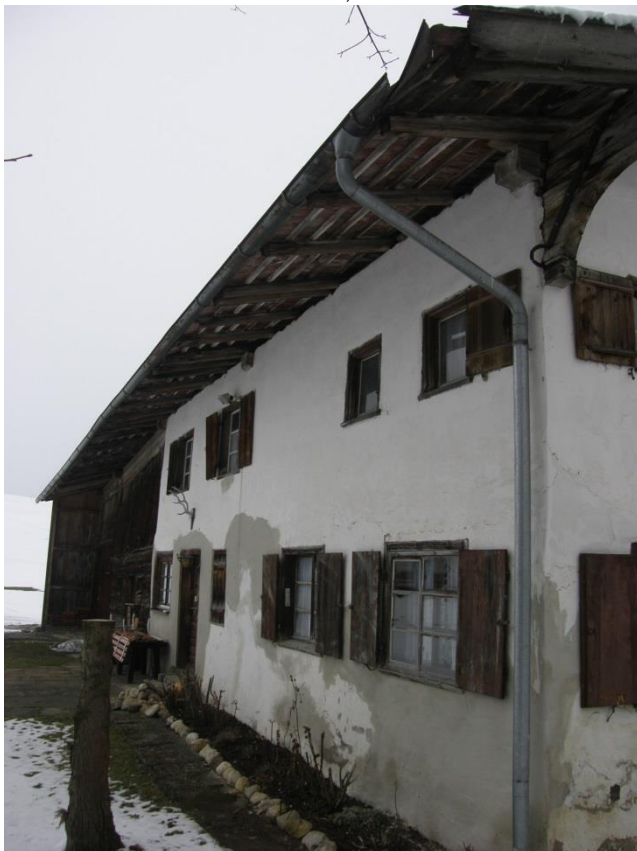
Unmittelbar angrenzende Bebauung mit direktem Bezug, Baudenkmal, ca. 22 Grad Dachneigung
